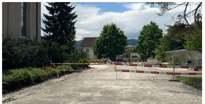
Der erste Abschnitt am Kirchweg, Au, ist bereit für die Belagsarbeiten.
