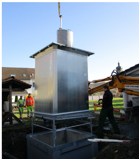
Einbau eines öffentlichen Unterflurcontainers an der Bachstrasse in Au.
