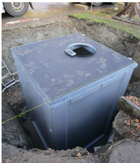
Einbau eines öffentlichen Unterflurcontainers an der Bachstrasse in Au.
