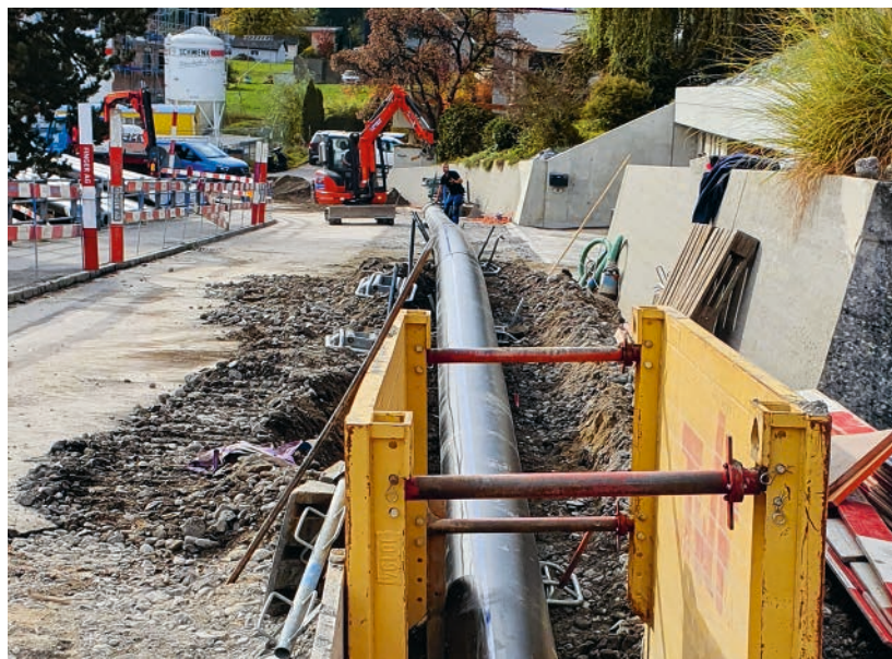
Umlegung der Transportleitung Grund-/Höhlerstrasse, Rebstein, 2. Etappe
