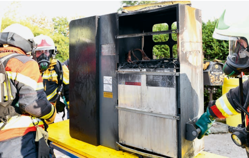
Brand Speicherbatterie, Au, 20. September 2020
