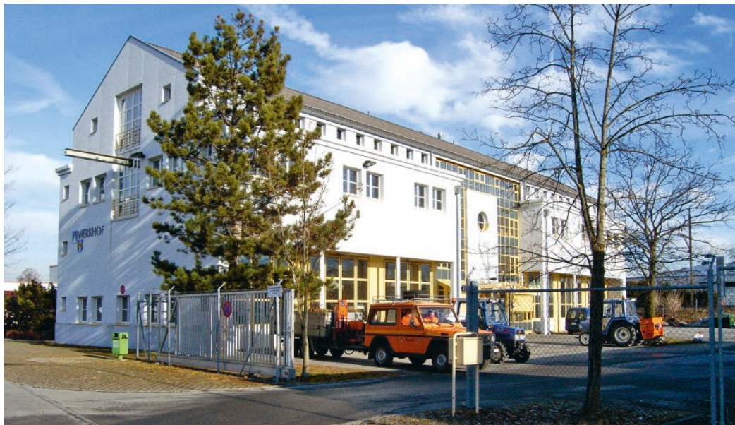
Werkhofgebäude, Feldstrasse 5, Au
