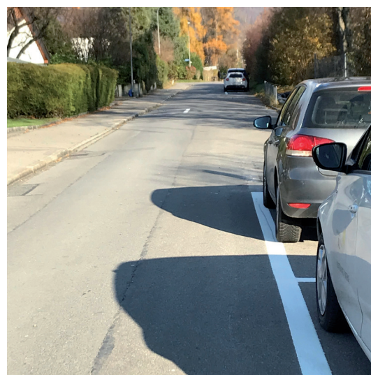
Die Verkehrsberuhigungsmassnahmen an der Römerstrasse mit acht Parkfeldern wurden erfolgreich umgesetzt.
