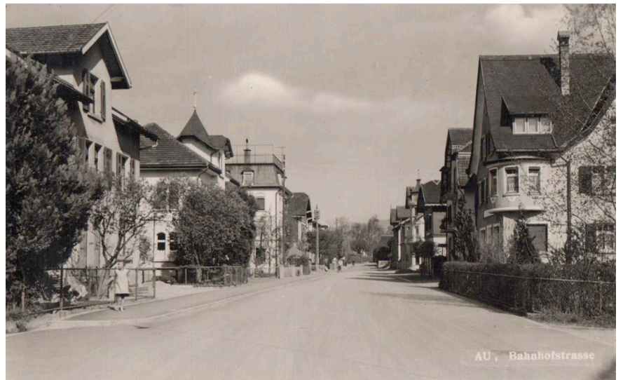
Abb. 20 Aufnahme Bahnhofstrasse (Blickrichtung Bahnhof), 1940, swiss.nailizakon.com
