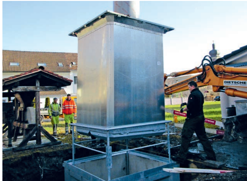
Einsetzen eines Unterflurcontainers
