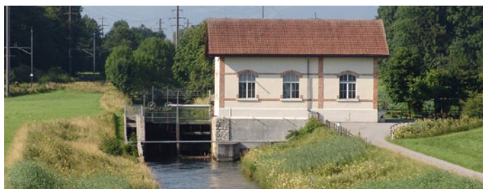
Kleinkraftwerk Lienz der St. Gallisch-Appenzellischen Kraftwerke AG (SAK)
