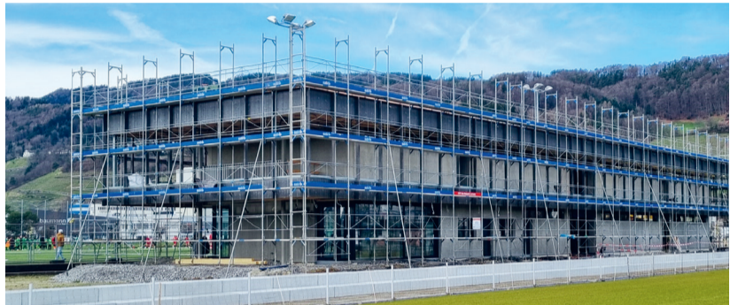
Foto aktueller Baufortschritt vom 2. März 2024
