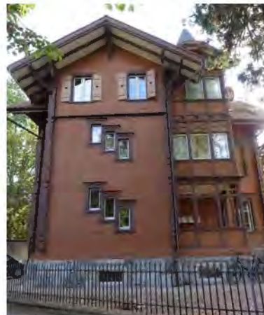
westseitige Fassade unter Quergiebel, Turmaufbau über Eingang
