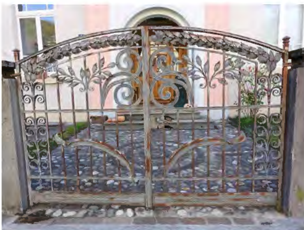
Aufwändig verziertes Gartentor vor dem Haupteingang
