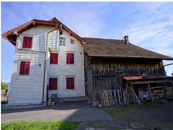
rückwärtige Fassade mit Anbau
