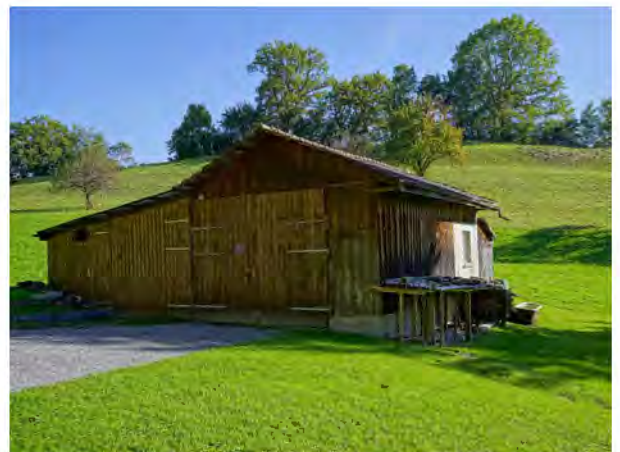
separat stehende Remise Ass. 989
