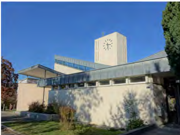
Ansicht Gesamtanlage aus Südwest
