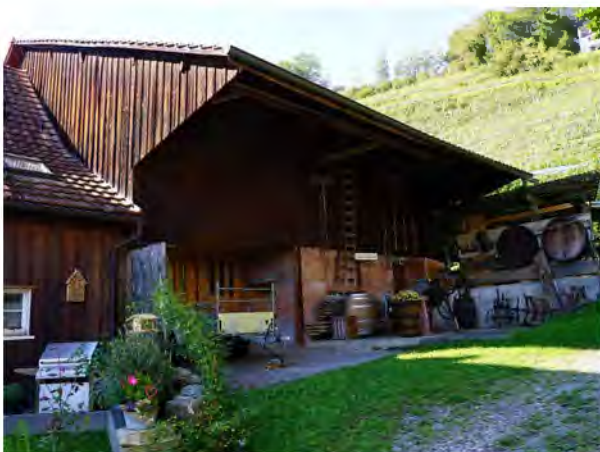
rückseitig angebaute Scheune Ass. 1267
