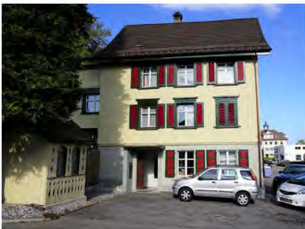
Westfassade mit Vorplatz und Gartenhaus
