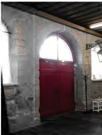
Natursteinmauerwerk Erdgeschoss
