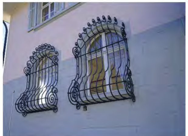
Details Sockel und Fenster Erdgeschoss
