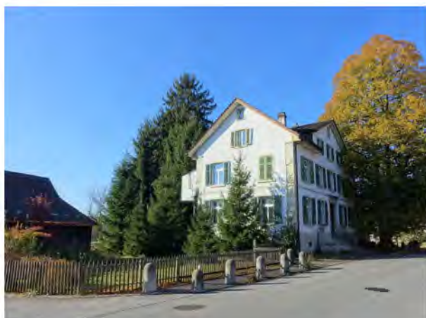
Gesamtsituation mit Nebengebäude auf dem Grundstück
