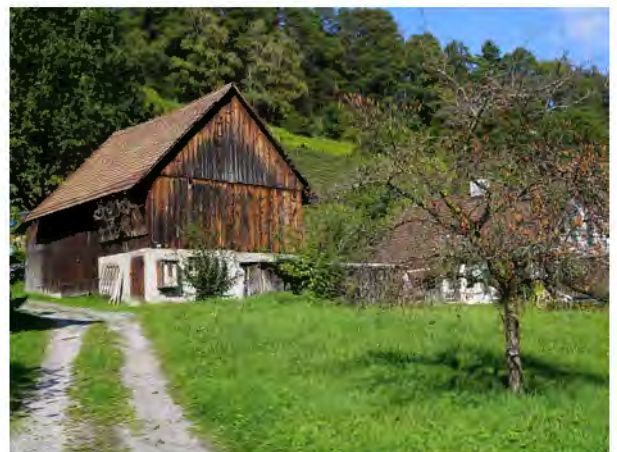
separat stehende Stallscheune Ass. 770 (Parz. 1222)
