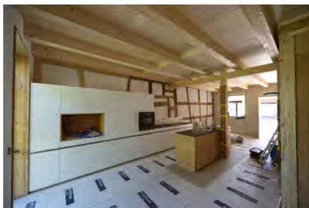
Innenansicht (Foto: Bänziger Lutze Architektur AG)
