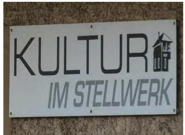
aktueller Nutzungszweck Stellwerk
