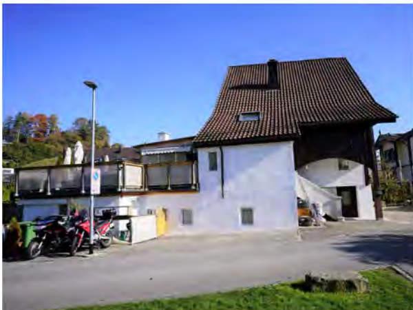
Anbauten am Gebäudeteil West
