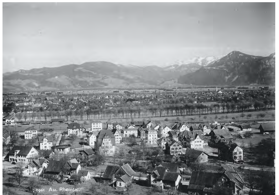
Abb. 19 Aufnahme Bahnhofsquartier, 1934, the.col- lectr.eu
