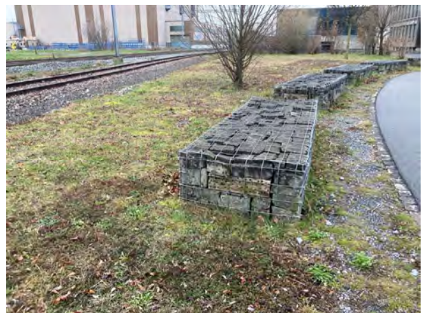
Abb. 10: Beispielbild mit Sandstein verfüllte Drahtschotterkörbe am selben Standort
