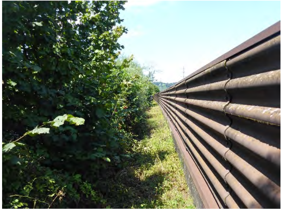
Abb. 2: Freigeschnittener Bereich entlang der Lärmschutzwand
