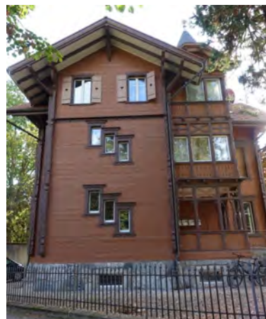
westseitige Fassade unter Quergiebel, Turmaufbau über Eingang
