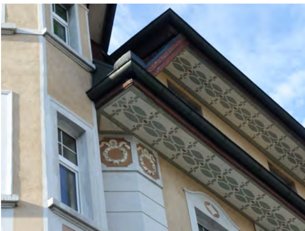
Verzierte Dachunterseiten und weitere Zierelemente
