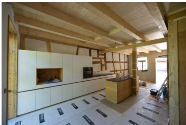
Innenansicht (Foto: Bänziger Lutze Architektur AG)
