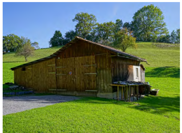
separat stehende Remise Ass. 989
