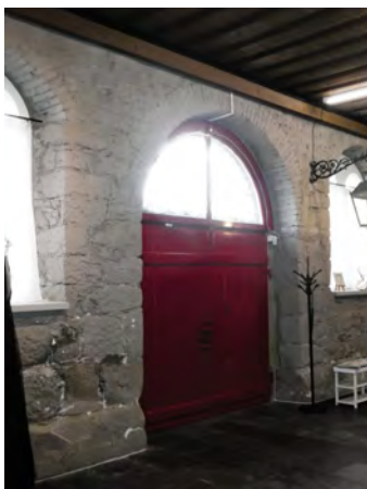
Natursteinmauerwerk Erdgeschoss
