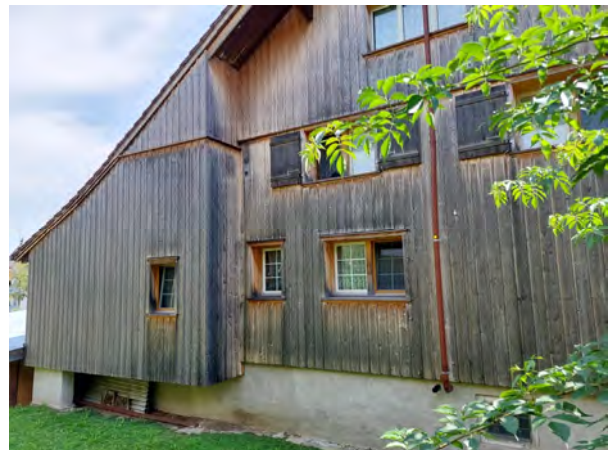
Details rückwärtige Fassade
