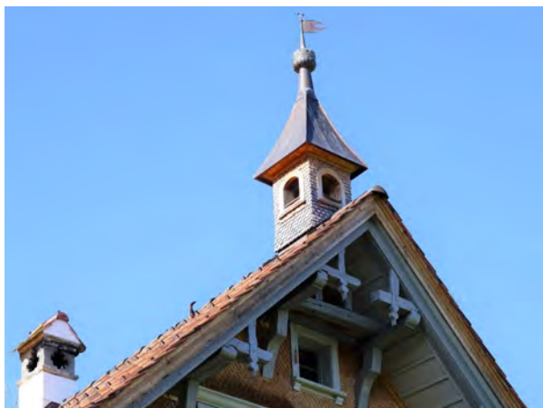
Detailansicht Giebelbereich und Dachreiter
