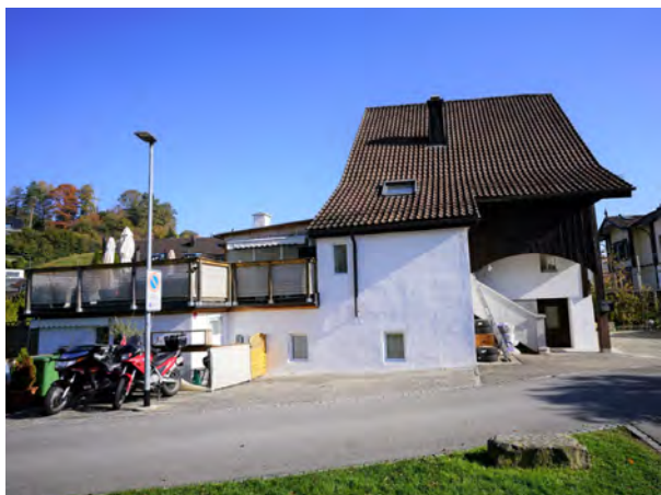
Anbauten am Gebäudeteil West
