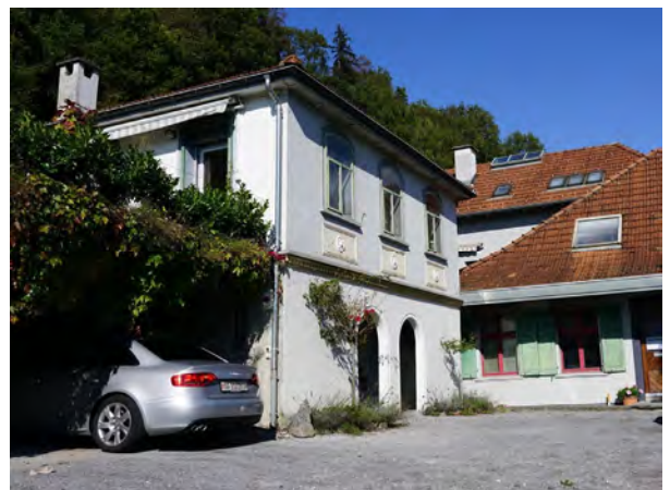
rückwärtiger Hofraum mit Nebenbaute Ass. Nr. 2
