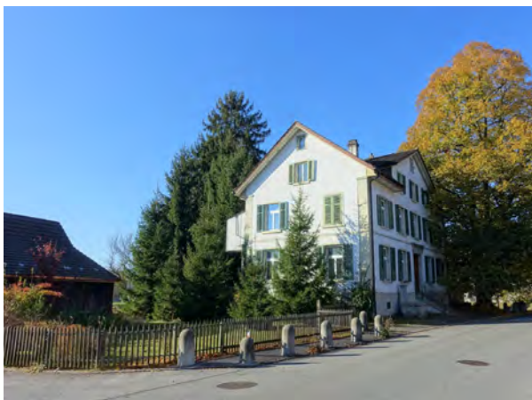
Gesamtsituation mit Nebengebäude auf dem Grundstück
