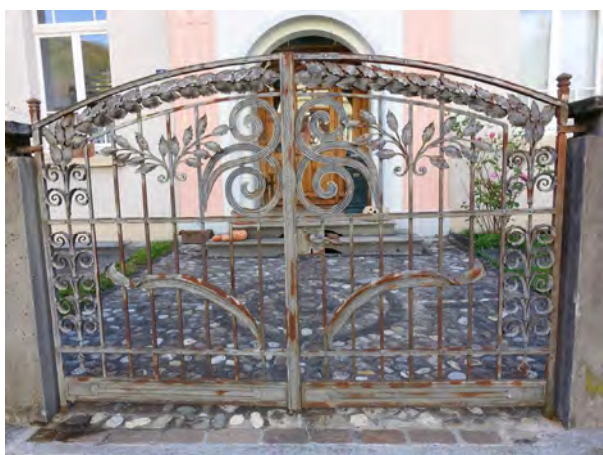
Aufwändig verziertes Gartentor vor dem Haupteingang
