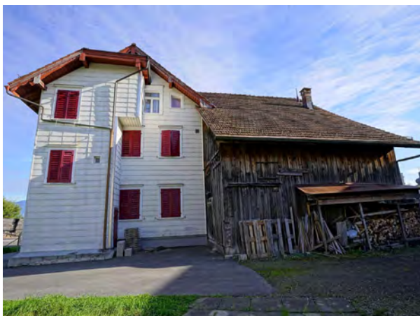
rückwärtige Fassade mit Anbau
