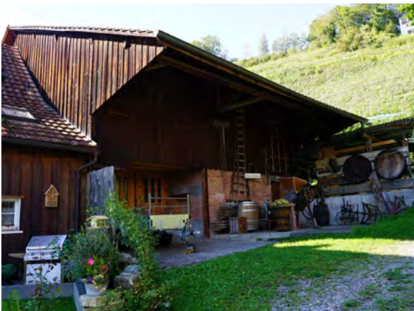
rückseitig angebaute Scheune Ass. 1267
