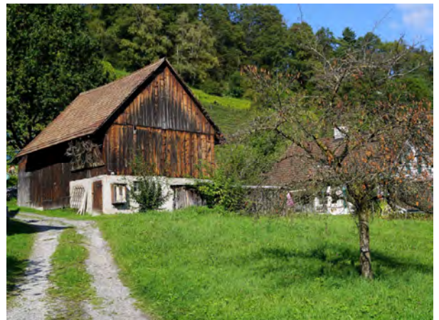
separat stehende Stallscheune Ass. 770 (Parz. 1222)
