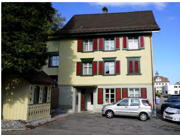
Westfassade mit Vorplatz und Gartenhaus
