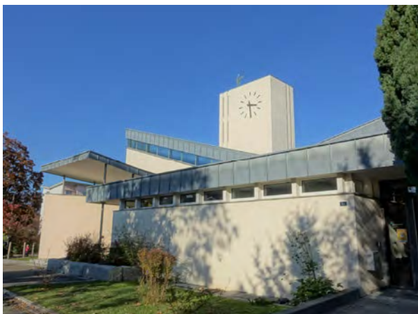
Ansicht Gesamtanlage aus Südwest
