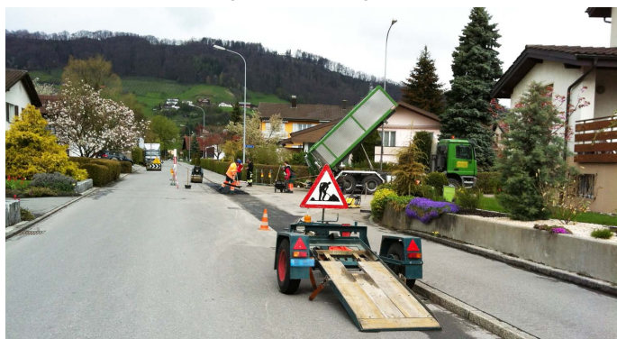
Bauarbeiten an der Emserenstrasse
