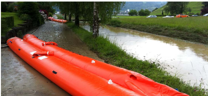
Wassersperren auf der Bachstrasse am Littenbach in Au
